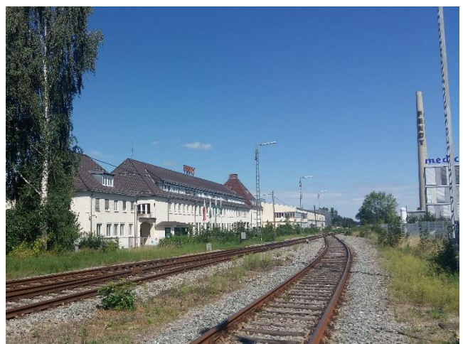
Blick von Süden (Bahnübergang Johann-Georg-Fendt-Straße) ent- lang der Bahnlinie
