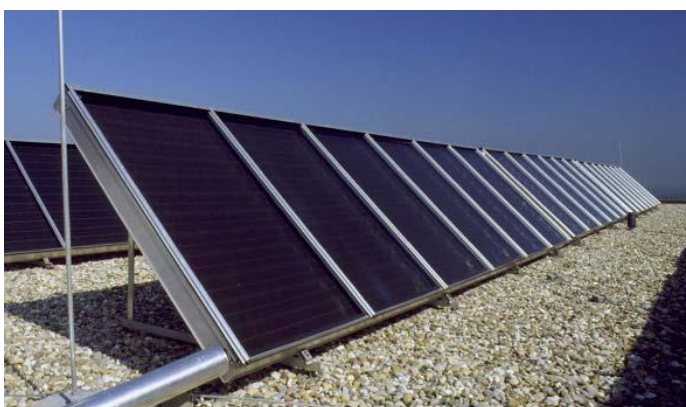
Abbildung 14: Darstellung aufgeständerte Solarthermiedachanlage [4]
