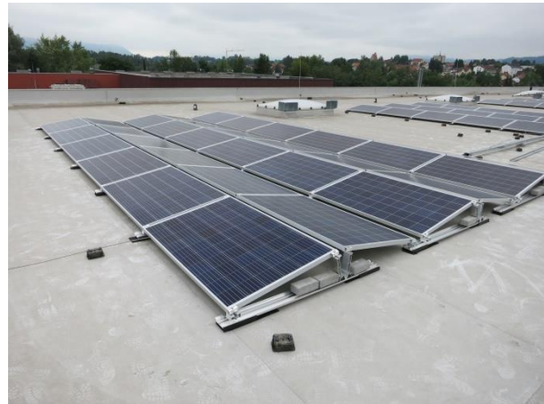
Abbildung 12: Beispielhafte Ost/West-Aufständigung einer PV-Anlage [3]
