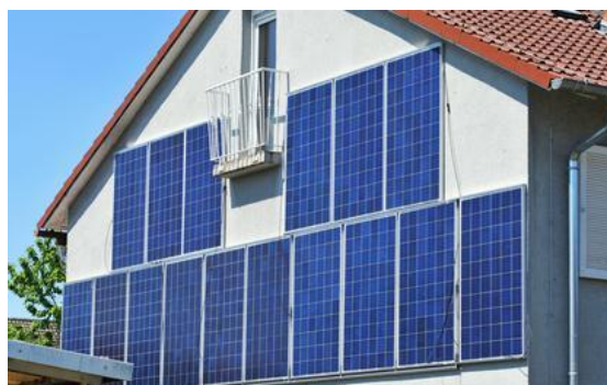
Abbildung 75: Darstellung des Konzept Fassaden-PV [12]
