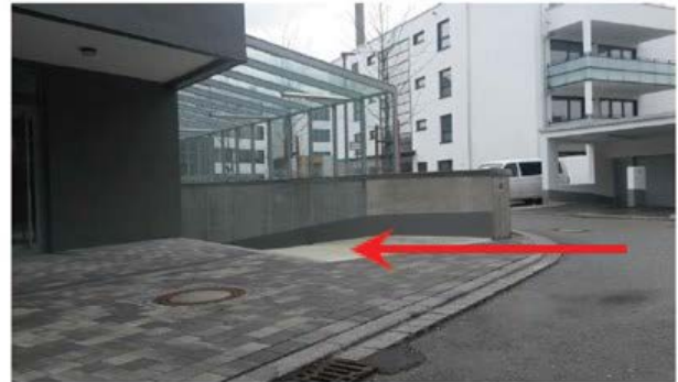
Abbildung 6: Mit einfachen Mitteln lassen sich im Rahmen der Bauvorsorge Risiken wirkungsvoll reduzieren. Beispielsweise kann bei Tiefgarageneinfahrten mit einer Schwelle weitgehend verhindert werden, dass Oberflächenwasser von der Straße aus eindringen kann (links). Im anderen Fall besteht die Gefahr, dass schon bei geringen Wasserständen auf der Straße Wasser in die Tiefgarage läuft (rechts). (Fotos: P. Geisenhofer – WWA Rosenheim)
