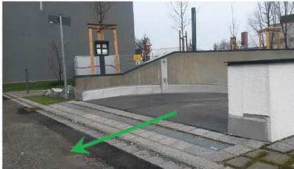
Abbildung 6: Mit einfachen Mitteln lassen sich im Rahmen der Bauvorsorge Risiken wirkungsvoll reduzieren. Beispielsweise kann bei Tiefgarageneinfahrten mit einer Schwelle weitgehend verhindert werden, dass Oberflächenwasser von der Straße aus eindringen kann (links). Im anderen Fall besteht die Gefahr, dass schon bei geringen Wasserständen auf der Straße Wasser in die Tiefgarage läuft (rechts). (Fotos: P. Geisenhofer – WWA Rosenheim)
